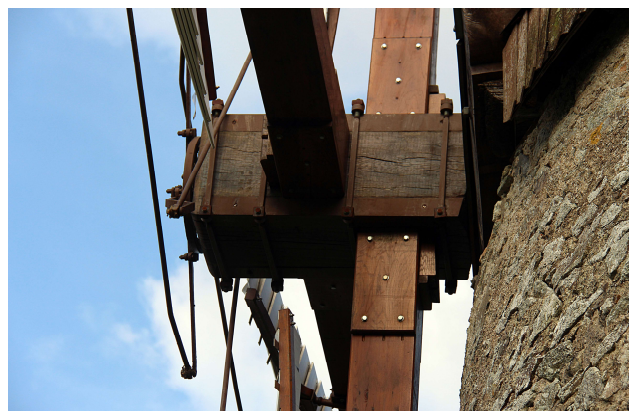
La Possonnière, moulin de la Roche, la tête de l'arbre supportant les ailes (Ph. Michel Raclin).
