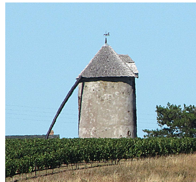
Ardenay, le Grand-Moulin avec sa guivre qui servait à faire pivoter son toit et orienter ses ailes face au vent.
