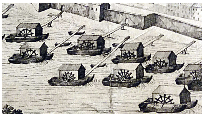
Un ensemble de moulins flottants ou bateaux (nefs flottantes).
