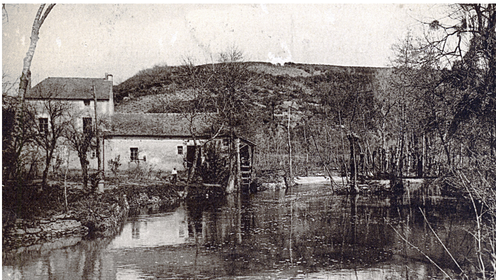
Sur le Layon à St-Aubin-de-Luigné, le Moulin de Gâteau, avec sa retenue d'eau. On aperçoit encore la roue à aube attachée au moulin, à l'abri d'un auvent.
