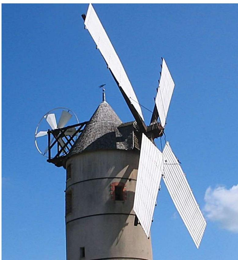
Certains moulins possèdent une seconde voilure, plus petite et orientée perpendiculairement aux ailes principales. Elle se trouve à l'arrière. La queue du moulin à disparu. Cette sorte d'éolienne appelé papillon sert à orienter le moulin automatiquement, si le vent tourne.
